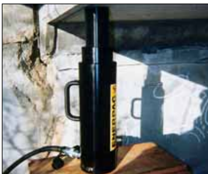
◀ Den bærbare låsemuttersylindren RACL-1506 benyttet til langvarig lastholding under innsprøyting av epoxy for broforsterking.
