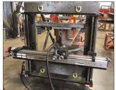
Fresing av I-bjelkes endeoverflate med GMRF1000. ▶
