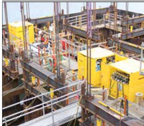
▲ Spesialtilpasset hydraulikkpumpe for et system for fremføring av brobane.
