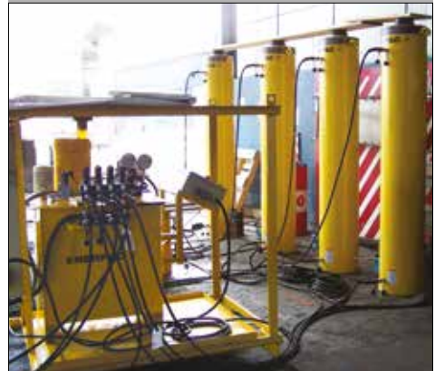
▲ Spesialtilpassede 500 tonns dobbeltvirkende sylindere med slaglengde på 1,83 m for å løfte elektriske vaiergravere.
