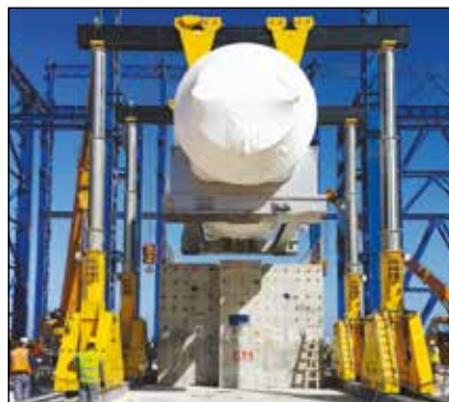
▼ SBL1100 teleskopiske hydrauliske traverser løser en stor generator for installasjon i et kraftanlegg.
